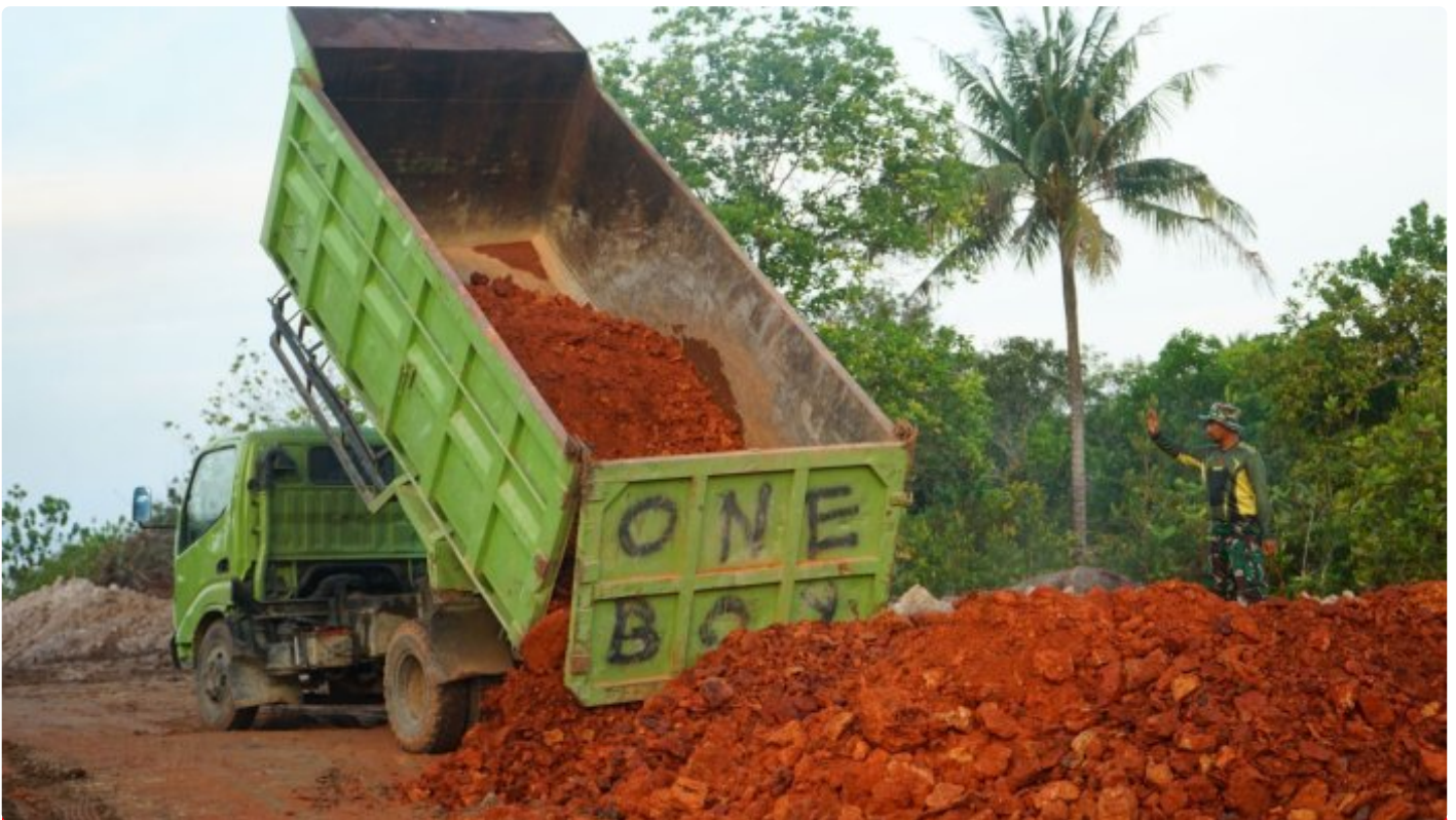
Percepat Pengerjaan Jalan,Material Dan Alat Terus DiKebut Satgas TMMD Di Tarakan
